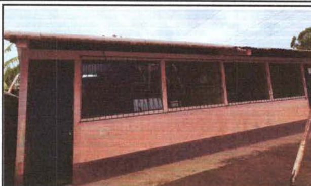
Foto 2: MANTENIMIENTO DE PARED Y CAMBIO DE TECHOS
