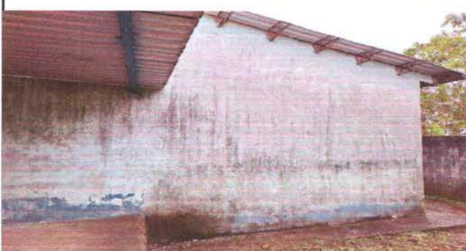
Foto 4: PINTURA DE PARED INTERIOR Y EXTERIOR
