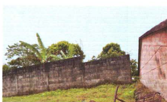
Foto 8: MANTENIMIENTO Y REPACION DE MURO PERIMETRAL 350 M2,
