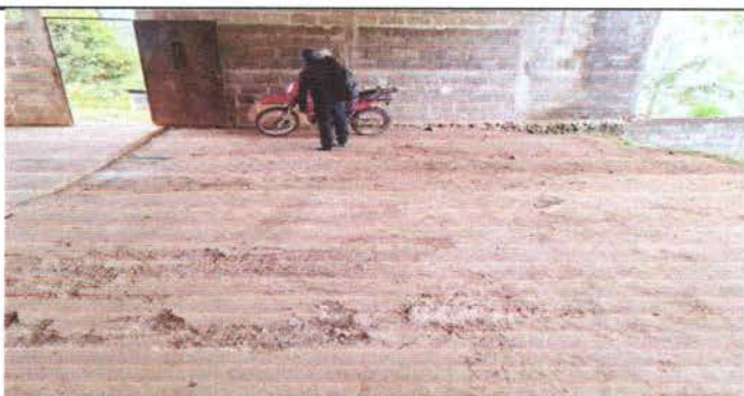
Foto 5: CAMBIO DE PISOS AREA 160 M2
