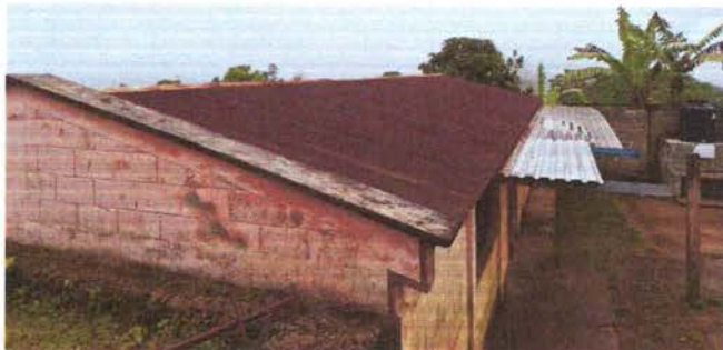
Foto7: MATENIMIENTO DE TECHOS y ENTORTADO CORREDOR
