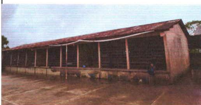
Foto 3: CAMBIO DE TECHOS Y PINTURA
