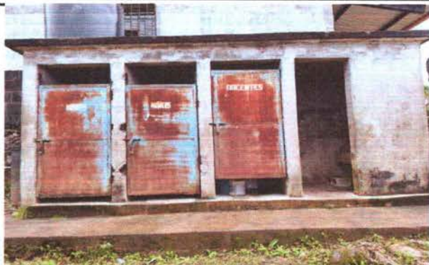
Foto 1: MANTENIMIENTO DE BAÑOS, PUERTAS Y PARED
